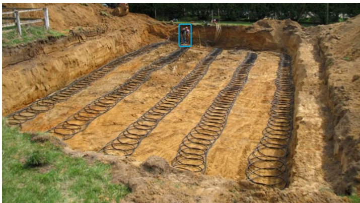
Figuur 8 Voorbeeld horizontale boring, met in blauw kader een persoon ter indicatie van de grootte [10]
